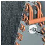
Brida de lámpara personalizada permite que la lámpara sea instalado directamente en Placa delta de bobina A para Exposición óptima a los rayos UV.
